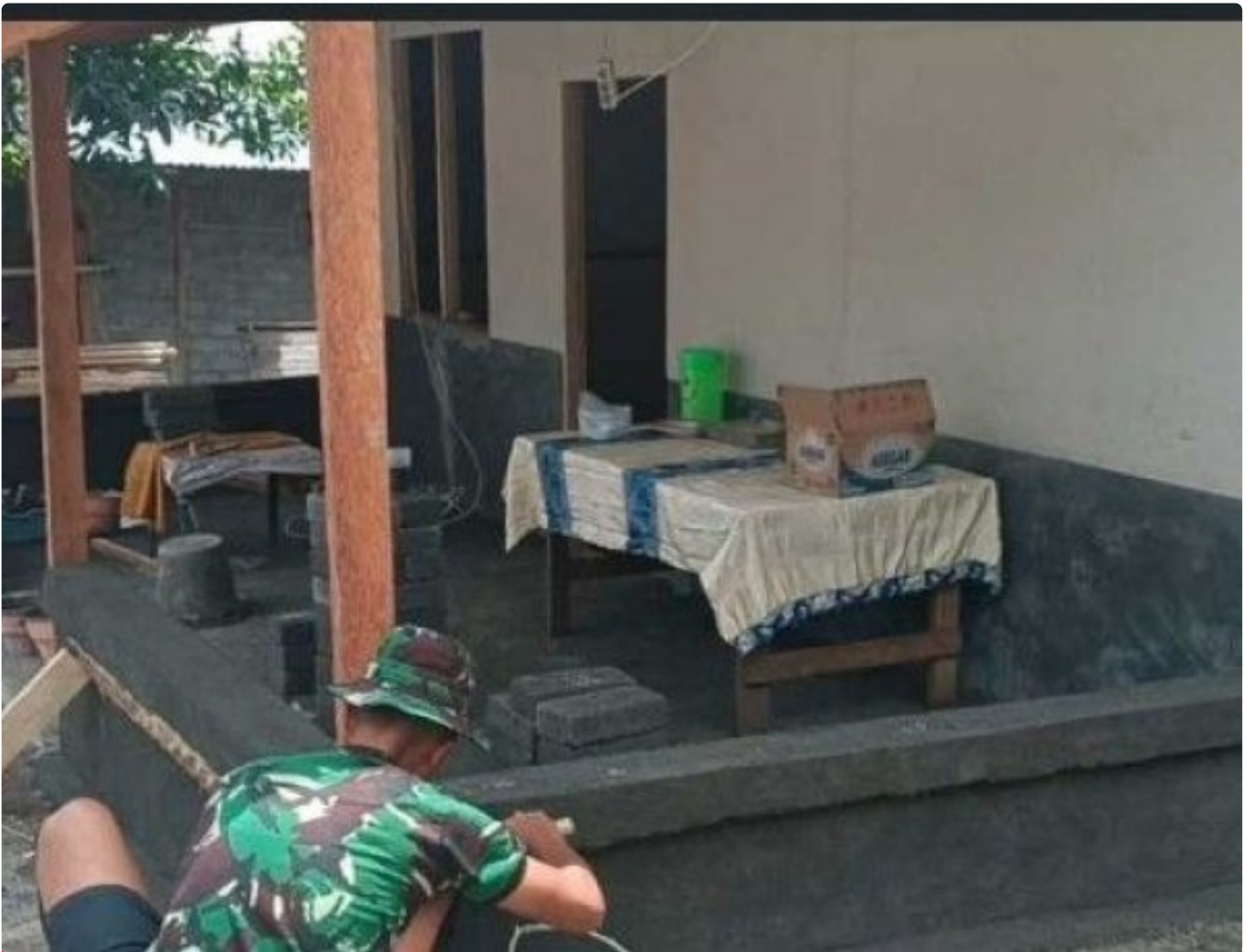
Satgas TMMD Kodim 1310 Bitung dalam Pekerjaan RTLH
