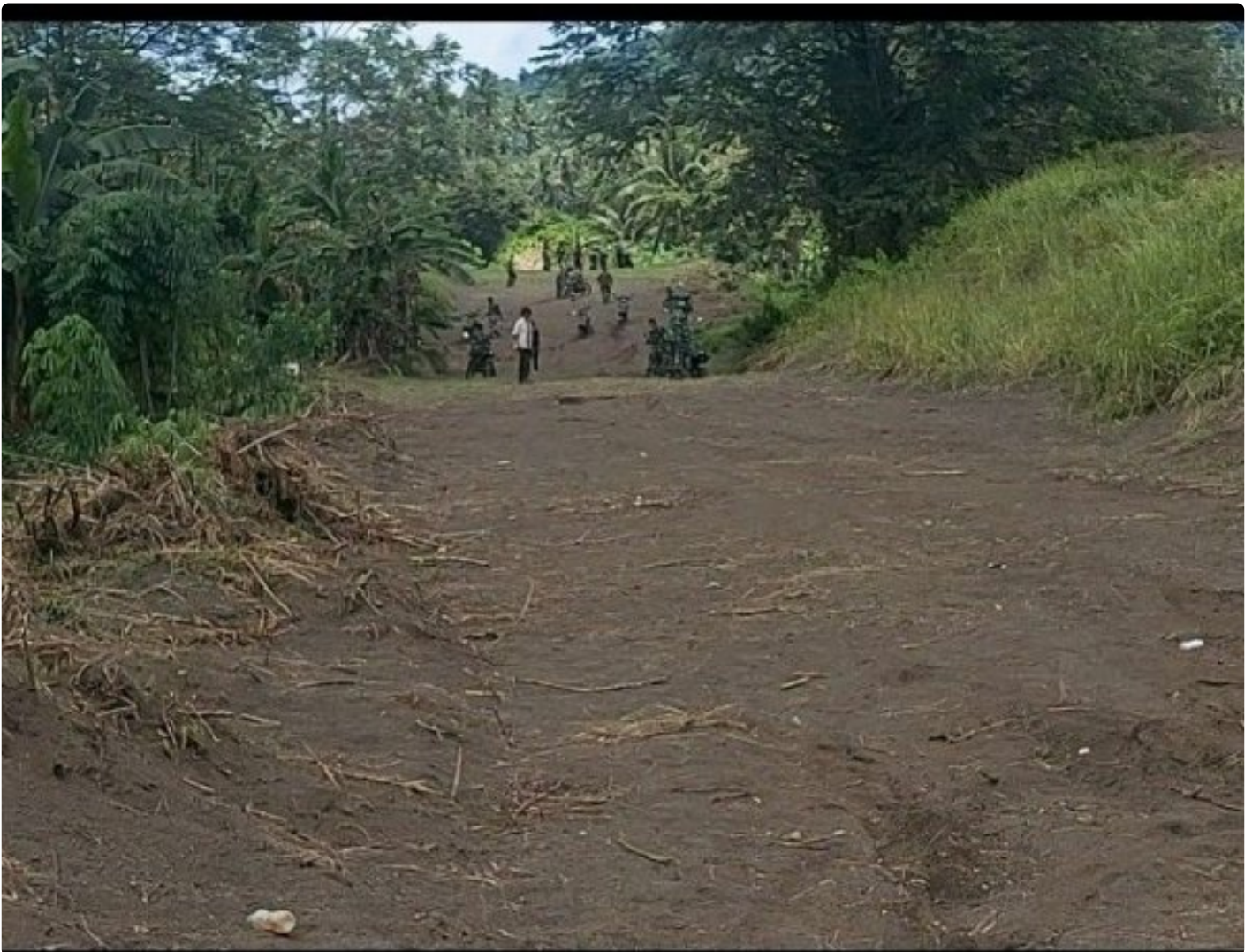
Pembangunan Jalan Penghubung Kelurahan Wangurer hingga Kelurahan Danowudu pada TMMD Ke-123 Tahun 2025 Kodim 1310 Bitung
